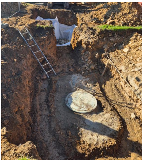
Fertigstellung der Installation am 26.10.2024
