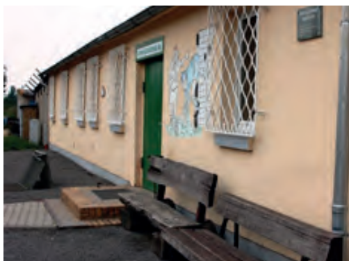
Vergitterte Fenster machen das Vereinsheim im Brandfall zur tödlichen Falle
