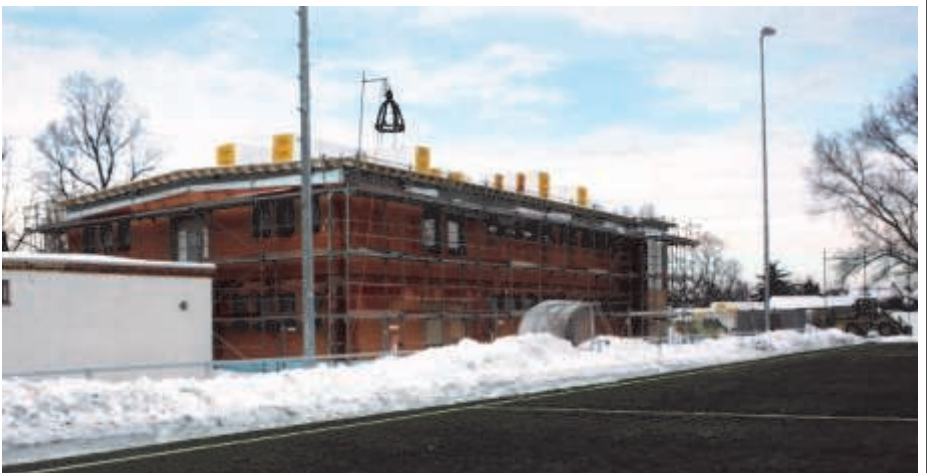
Am 06.12.2010 feierte der SFV auf der Sportanlage am Gontardweg in Leipzig das Richtfest zum Bau des Sanitärtraktes.
